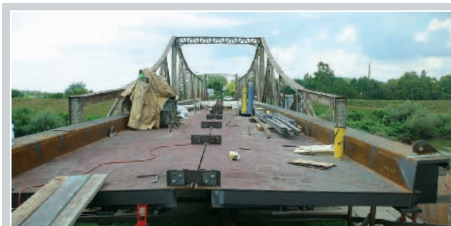
7-8. kép: A keresztbordás ortotrop acél pályalemez rögzítése és illesztése
