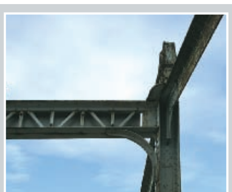
14-15. kép: A rácsos kapuzat felújítás előtt és után, ütközés elkerülésére magasabbra helyezve
