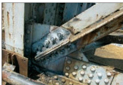
10. kép: A szegecsek helyettesítése NF-csavarokkal
