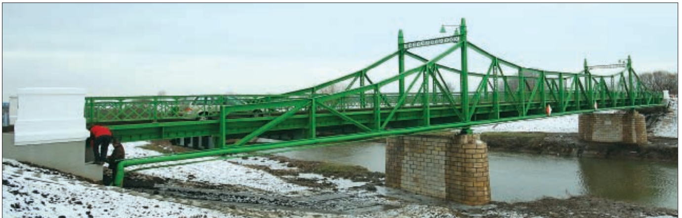
18. kép: A kész híd, tervezői konzultáció és minőségellenőrzés a hídfőnél
