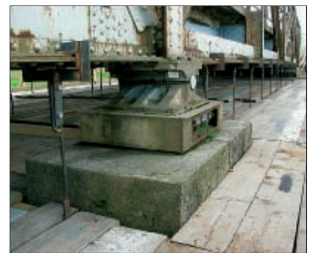
4. kép: Az állványzat függesztése és a híd csuklós-görgős saruja
