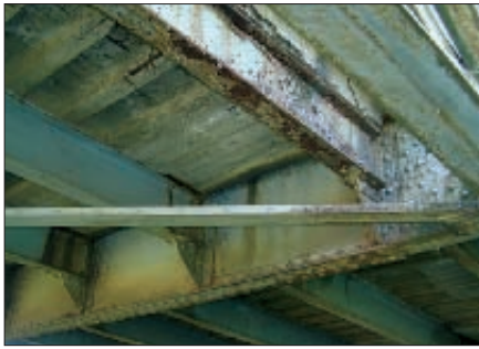
3. kép: Az eredeti híd alulnézete a közel 100 éves sűrűbordás vasbeton pályalemezzel
