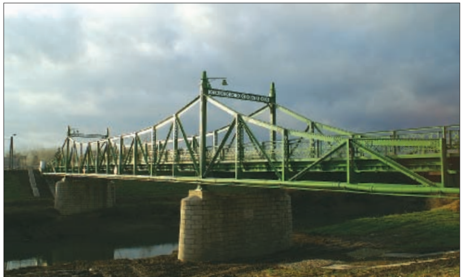
19. kép: A kész híd
