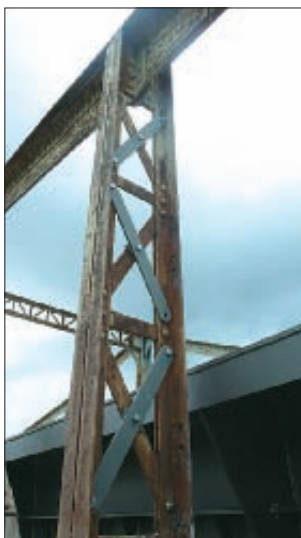
9. kép: Az osztott szelvényű oszlop megerősítése
