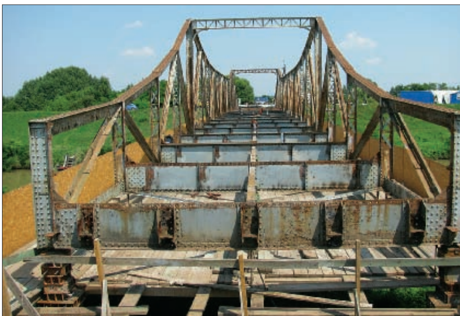
6. kép: A csupasz megtartott szerkezet
