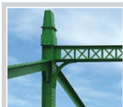
14-15. kép: A rácsos kapuzat felújítás előtt és után, ütközés elkerülésére magasabbra helyezve
