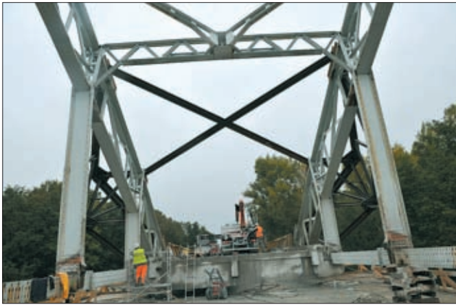
14. kép: A szerkezet építése: az ív ideiglenes merevítése elkészült, a vasbeton pályalemez bontása halad, az ideiglenes rácsos vég-kereszttartó beépítéséig a tartóbetétes beton vég-kereszttartó még bent maradt
