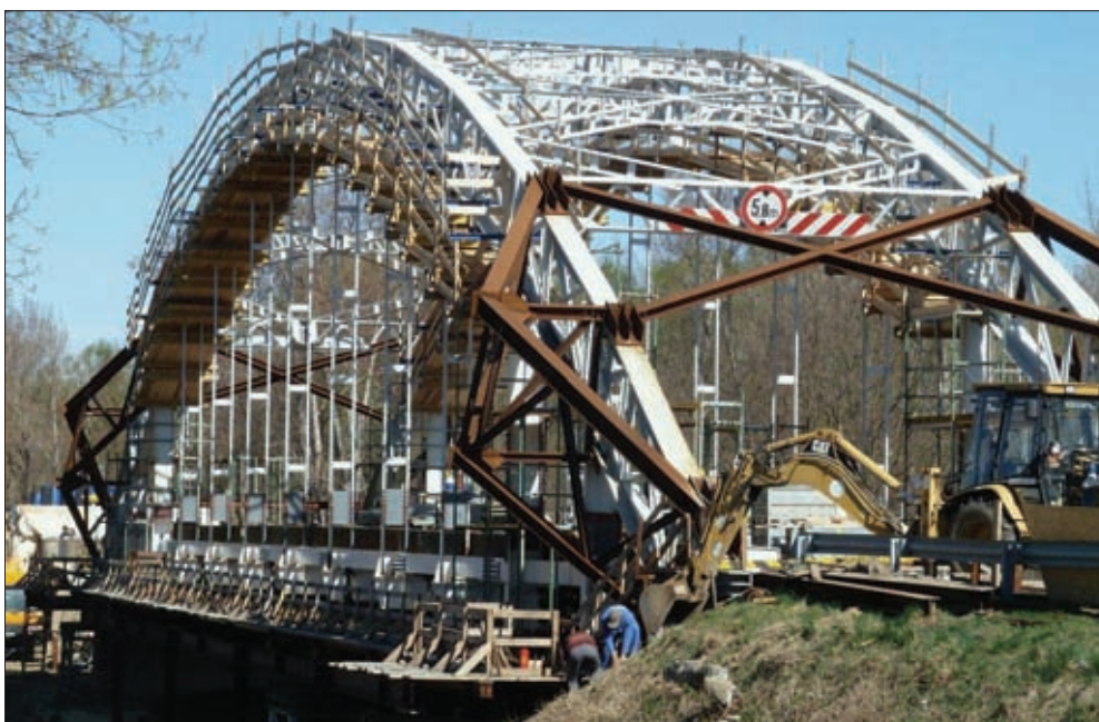
16. kép: A szerkezet építése: a főtartó ív felújítása
