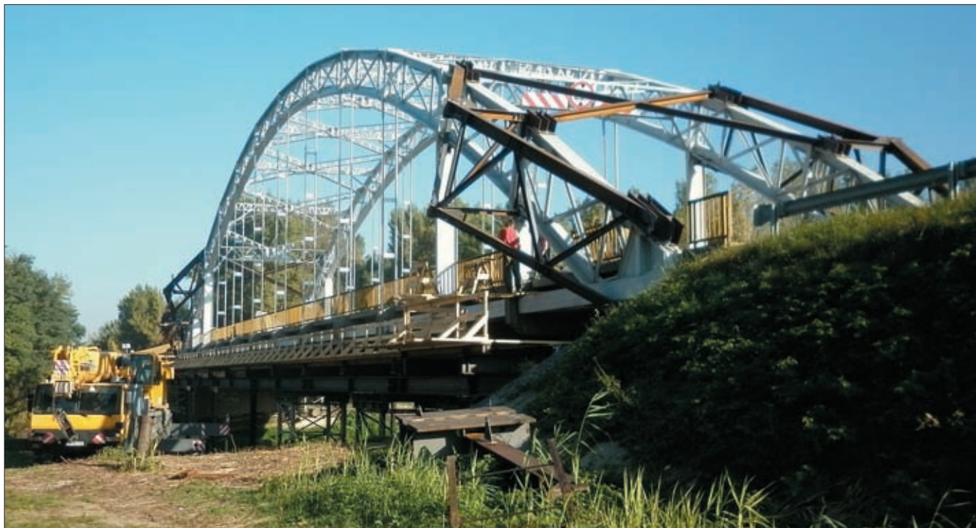
13. kép: A szerkezet építése: az ívmerevítés installálása
