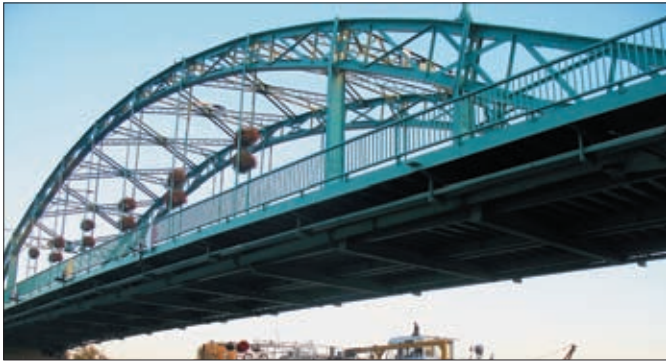
2. kép: a ráckevei Árpád híd felújítása
