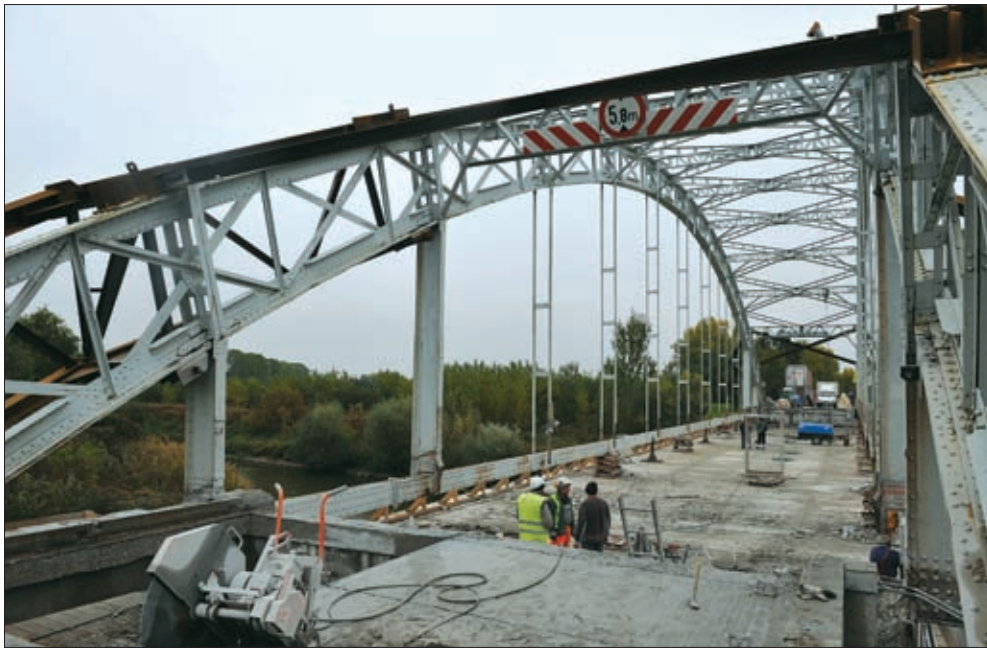
15. kép: A szerkezet építése: a vasbeton pálya táblás bontása
