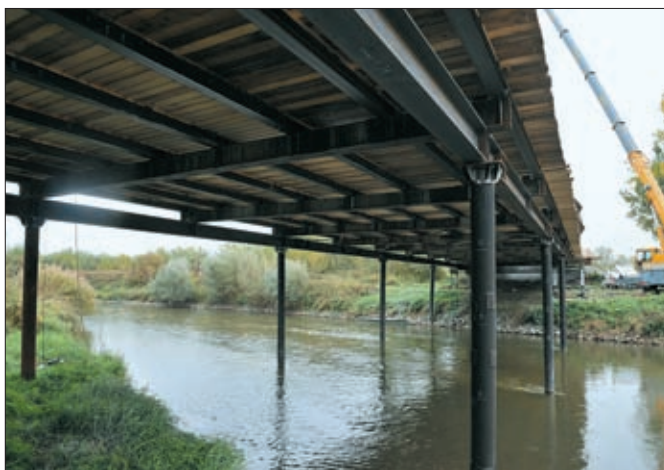
5. kép: A bontóállvány a híd alatt: vert csöcölöpök, karcsú szerkezeti kialakítások
