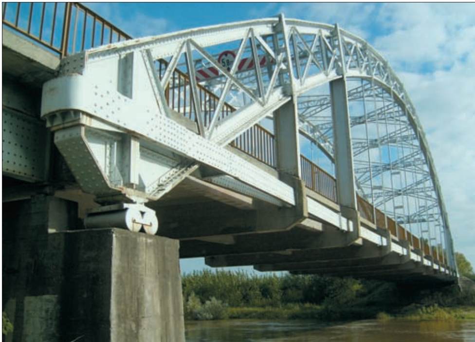
4. kép: A marcaltói Rába-híd mederszerkezete az átépítés előtt
