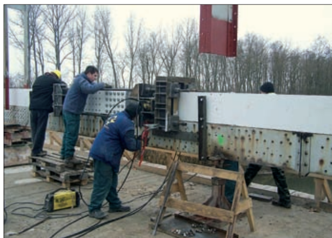
12. kép: A szerkezet építése: A vonórúd kiváltáshoz készített feszítőrendszer
