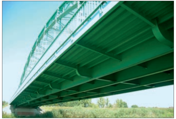
3. kép: A szeghalmi Berettyó-híd ortotrop acél pályalemeze
